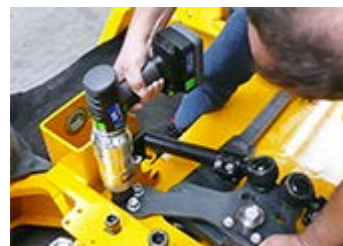
建機の組立、ボルト締めメンテ
