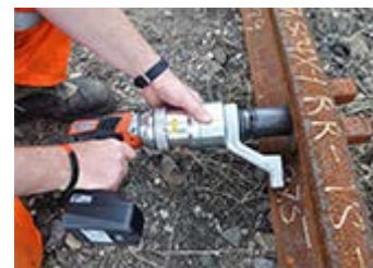
線路の枕木ボルト締め
