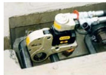
奥まった狭いボルト締め作業。
